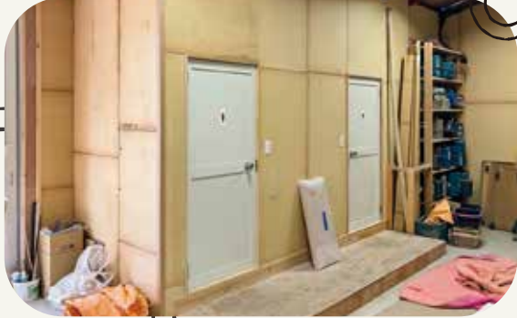
広々とした入口に 資材置き場とトイレを完備
