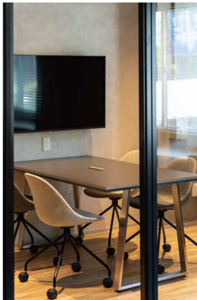
室内への採光を考慮しガラスパーテーションとした会議室。
