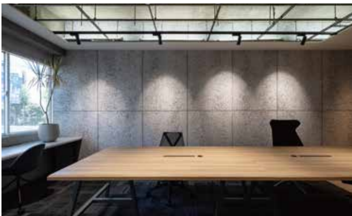
遮音・吸音効果のある木毛セメント板を壁面に使用。
